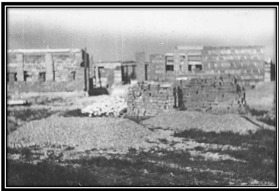
Pierwszy etap budowy
